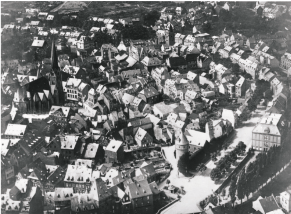
ABB. 5 Mayen aus der Luft: frühe Luftaufnahme von der nördlichen Innenstadt, 30er Jahre.
