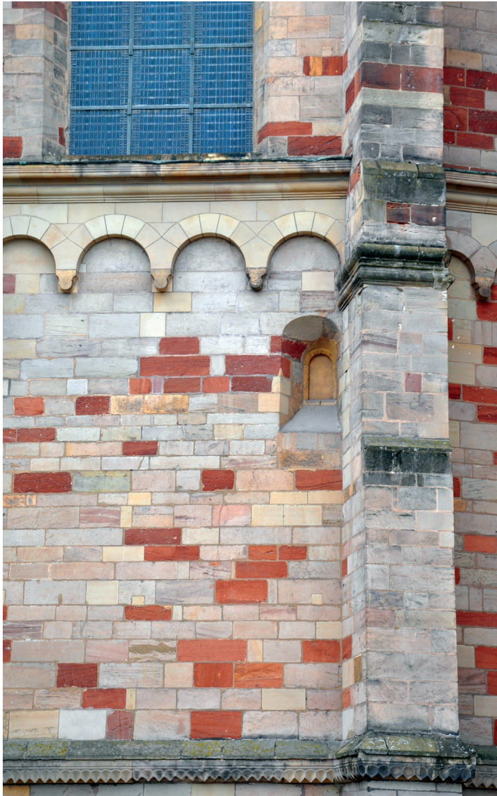
Abb. 8: Trier, Dom, Ostchor, vermauerter, fensterförmiger Oculus (F. M. Groß-Morgen)
