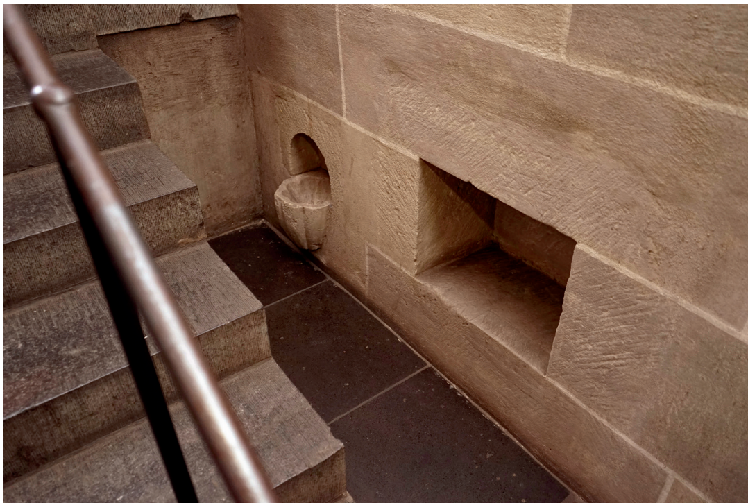
Abb. 14: Trier, Dom, südl. des Ostchor gelegener ehem. Altarstandort mit Piscina und Wandschrank (F: M. Groß-Morgen)
