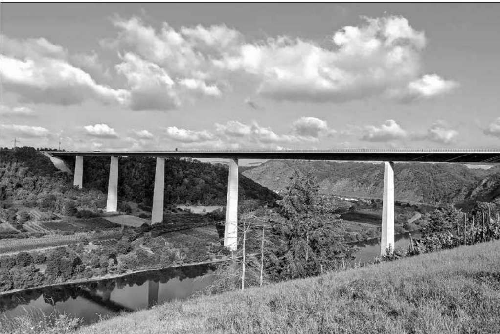
Die Moseltalbrücke mit Blick auf Dieblich
