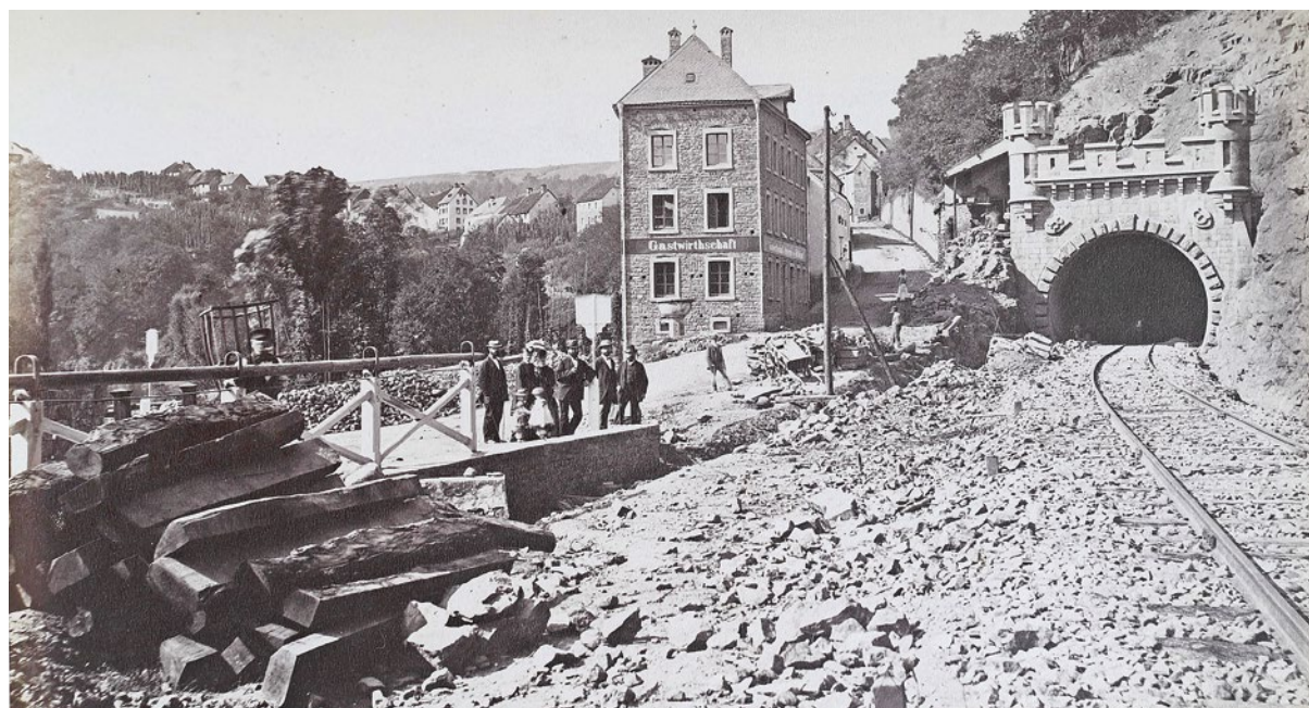
Blick auf Kyllburg und Tunnel.
